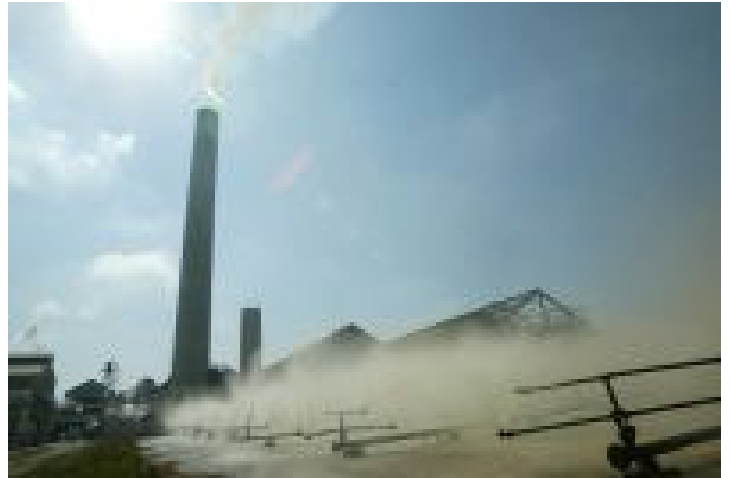
Getti d'acqua del sistema di raffreddamento della Centrale dello Zucchero López Peña nella località di Baguanos, Holguín, Cuba
